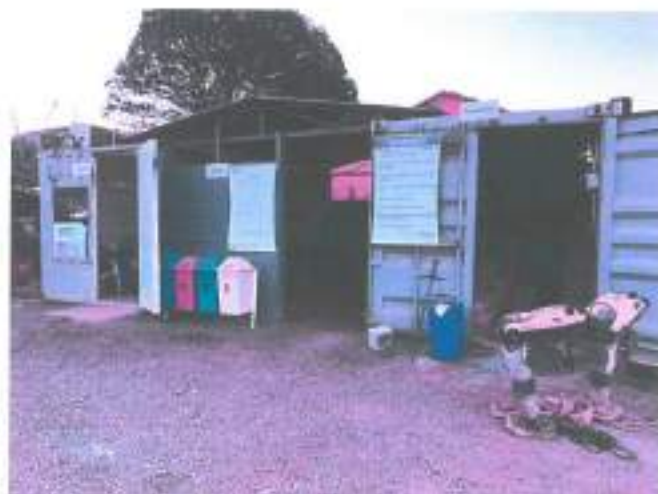
FOTO 30: INSTALAÇÕES PROVISÓRIAS DO CANTEIRO DE OBRAS.
